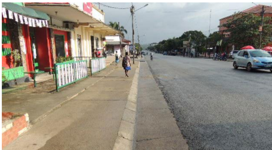
Figura 7-7. Pormenor de canaleta com lancil galgável
