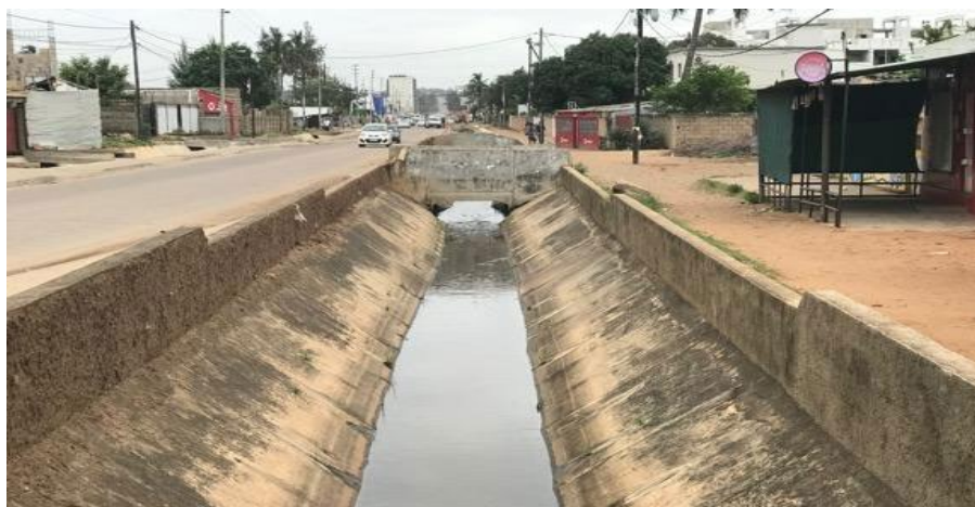
Figura 7-4. Vala adjacente ao pavimento
