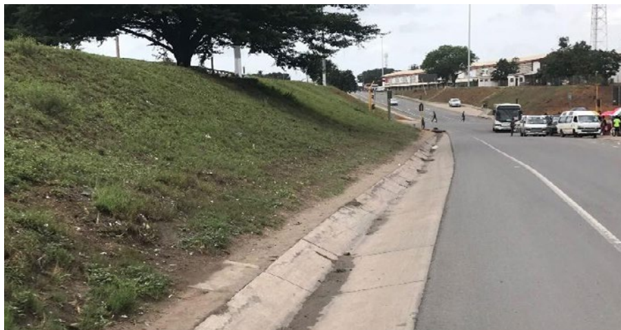
Figura 7-6. Valeta de pé de talude
