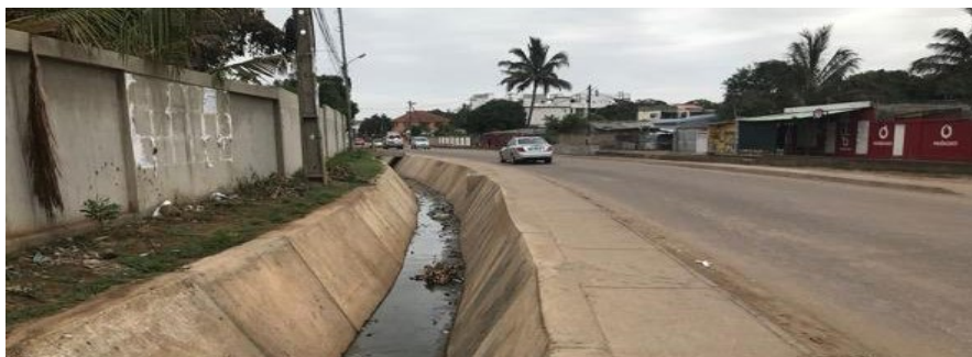
Figura 7-3. Vala de bordadura de passeio
